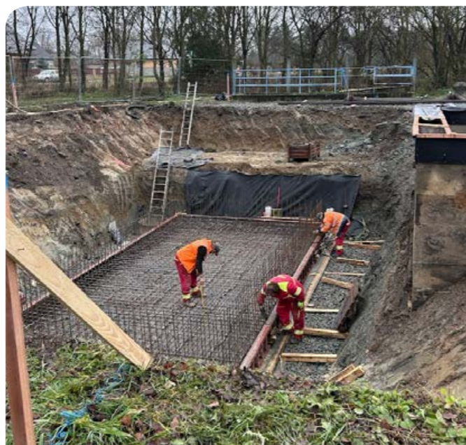
Práce na denitrifikační nádrži.
