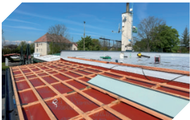
Rekonstrukce střechy na fotbalových kabinách, jaro 2024
