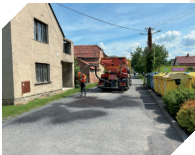
Tradiční jarní opravy místních komunikací
