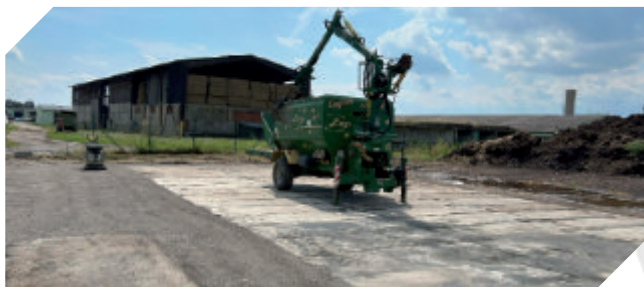
Nově zpevněná plocha na kompostárně, srpen 2024
