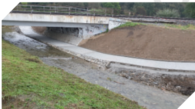
Podjezd pro cyklisty pod železničním koridorem (Trusovický potok)
